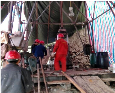
图:安全检查现场
