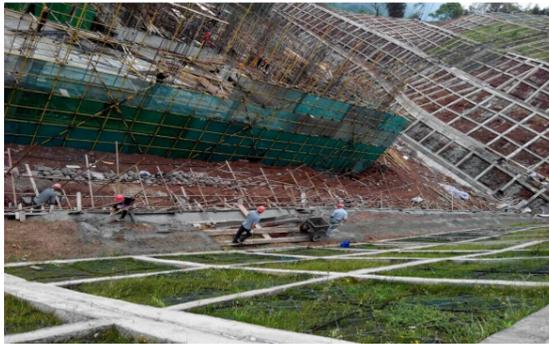
从南岸西区鲁能 B07 施工工地的斜坡地段向下看，整齐方正的框架梁仿佛向来往的人们述说着施工者精湛的工艺技术。这是我队勘察院受宜宾鲁能开发(集团)有限公司委托，承担的山体边坡设计治理工程，采用的是锚杆框架梁护坡治理方案。项目负责人吴晗和刘洪目光如炬地审视着工地上的工作，不时比划指导，不放过一个细节；头戴安全帽的工人们正紧张的进行着坡面绿化等收尾工作，专心致志，有条不紊。在西区的还有些荒凉的工地上，忙碌、有序成了现场最直观的代名词。
